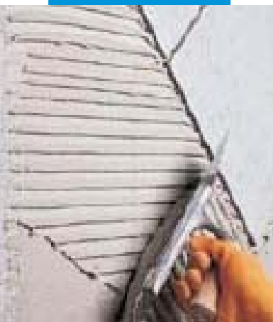
2. Lepení předleštěného mramoru na podlahu
