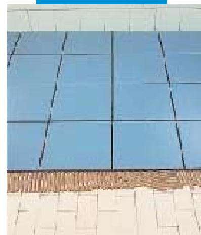
5. Lepení obkladů na již existující obklady šedým Keraflexem
