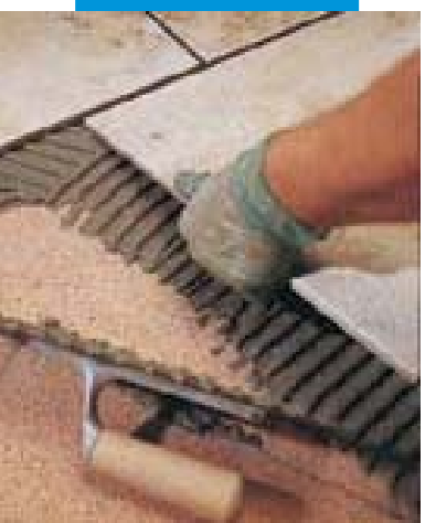
3. Lepení jedenkrát pálených obkladů na stěnu z panelů z pěnového betonu
