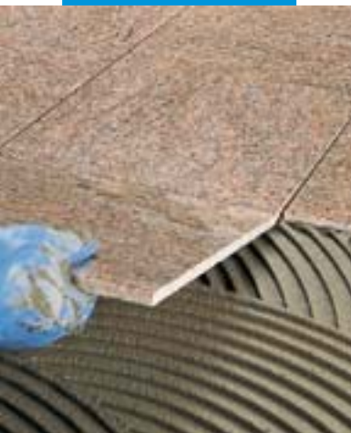
1. Jedenkrát pálený obklad na obkladu teraco na venkovní zdi
