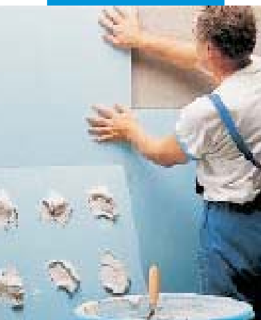
4. Lepení pěnových polystyrénových plátů bílým Keraflexem
